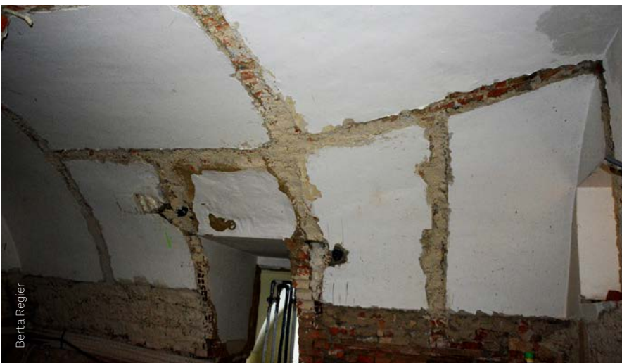
Die Gewölbedecke wird wieder hergestellt.
