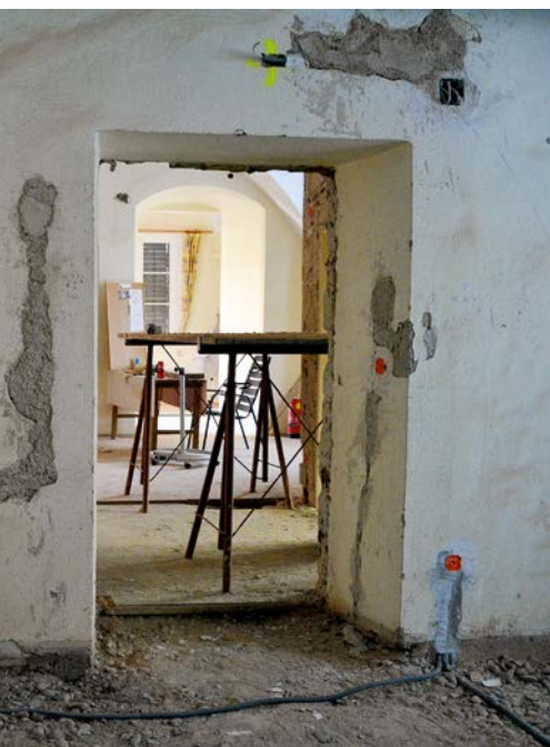
Alle Sanitärleitungen werden erneuert.
