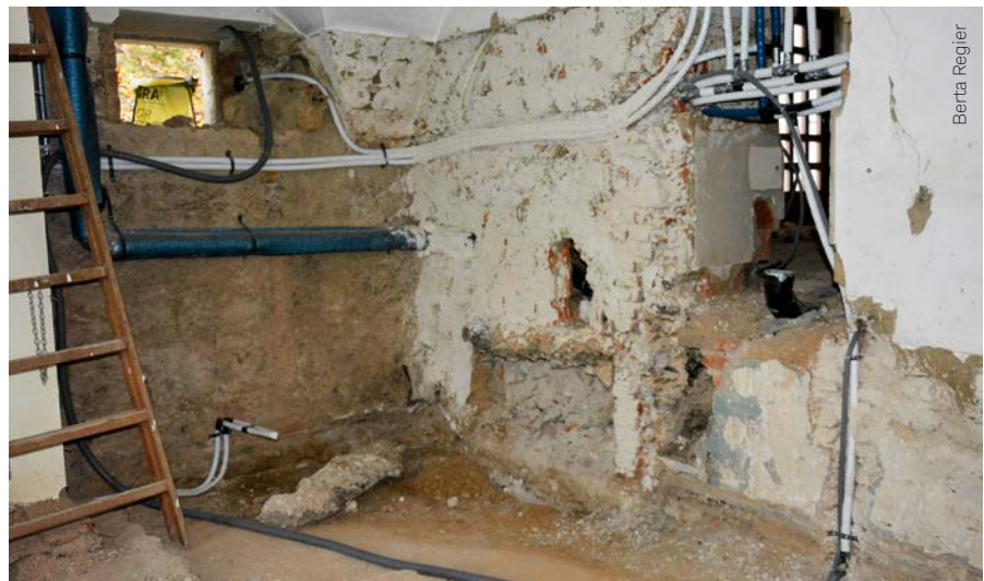
Alle Sanitärleitungen werden erneuert.
